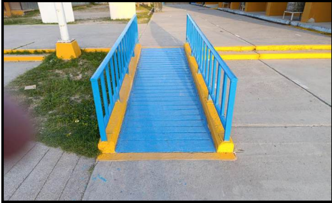
Fotografía 15 Pintura de las rampas de acceso
